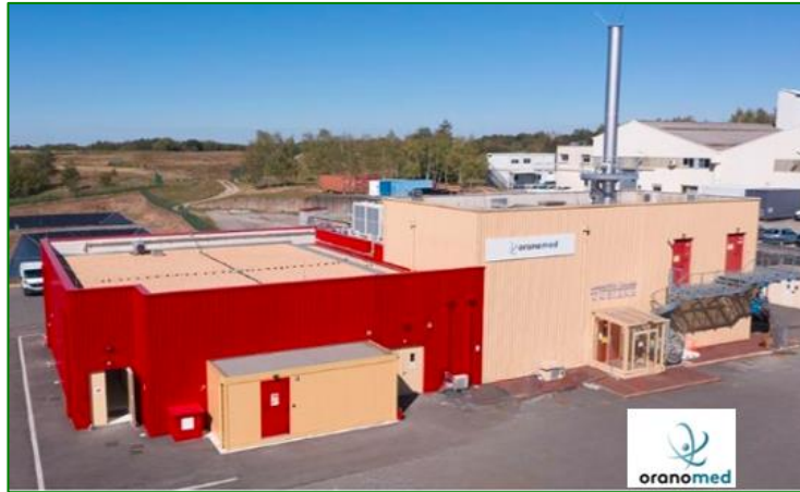
Figure 18 : Vue de l'installation LMT (installation existante)
