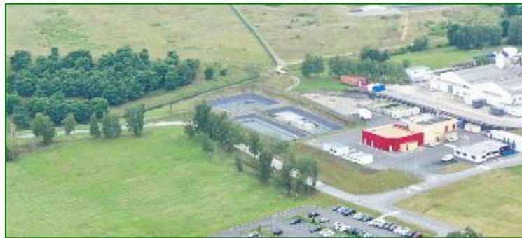
Figure 19 : Vue aérienne de la plateforme du LMT (installation existante)
