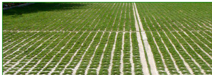
Figure 9 : Exemple de béton drainant végétalisé
