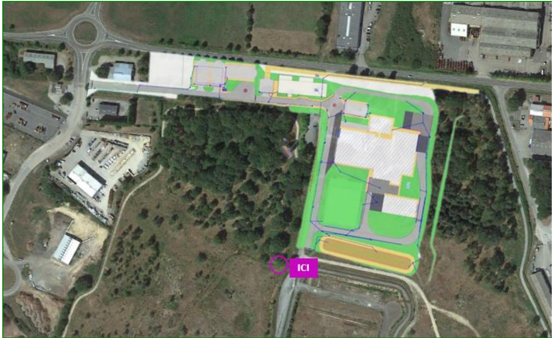
Figure 8 : Point de rejet des eaux pluviales « zone industrielle »
